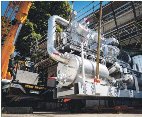
**Zukunft** Bis 2035 wollen die Stadtwerke Duisburg CO<sub>2</sub>-neutral sein. Eine Kraft-Wärme-Kopplungs-Anlage soll helfen, dieses Ziel zu erreichen. Mit dem Anschluss der beiden 1,9 Megawatt starken Wärmepumpen hat das Projekt einen weiteren Meilenstein erreicht. Bild: © Stadtwerke Duisburg
